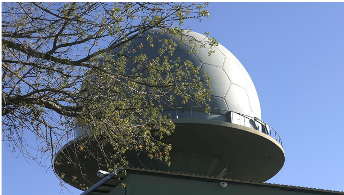
Imagem 7: Radome da Antena
