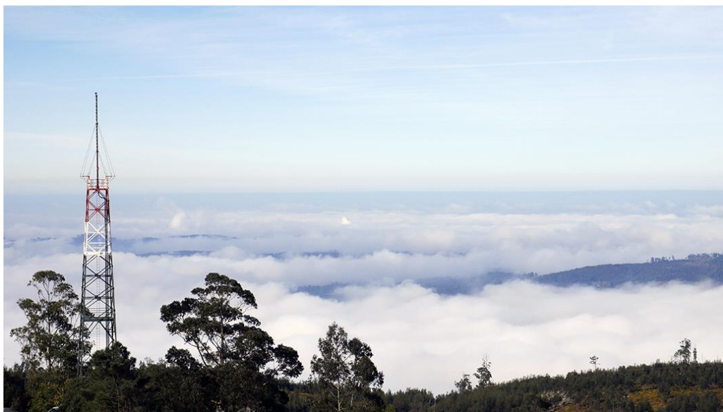
Imagem 6: Vista da Antena do Radar
