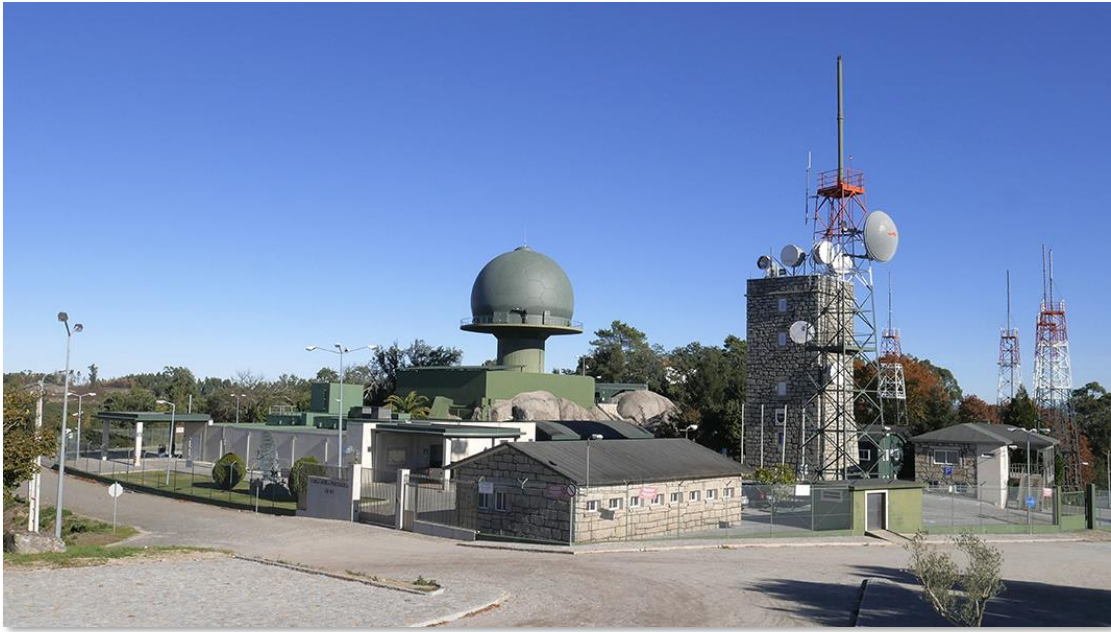
Imagem 2: Vista exterior da ER2
