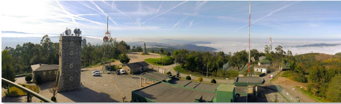
Imagem 4: Vista aérea da ER2
